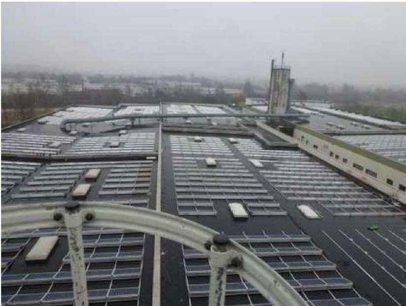
Photovoltaikanlage ca. 585 kWp Nähe Minden, Nordrhein-Westfalen, Belegung mehrerer Fabrikhallen mit monokristallinen Modulen und einem dachdurchdringungsfreien Montagesystem
