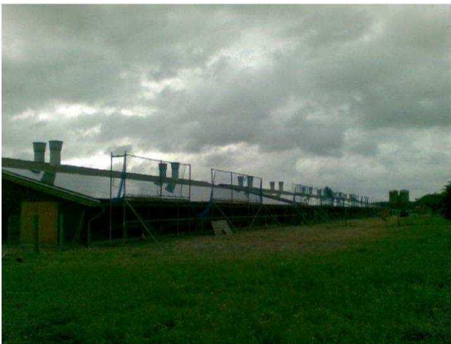
Photovoltaikanlage ca. 118 kWp in Buchholz/Müritz, Mecklenburg-Vorpommern, Belegung von BioHühnerställen mit micromorphen Dünnschichtmodulen
