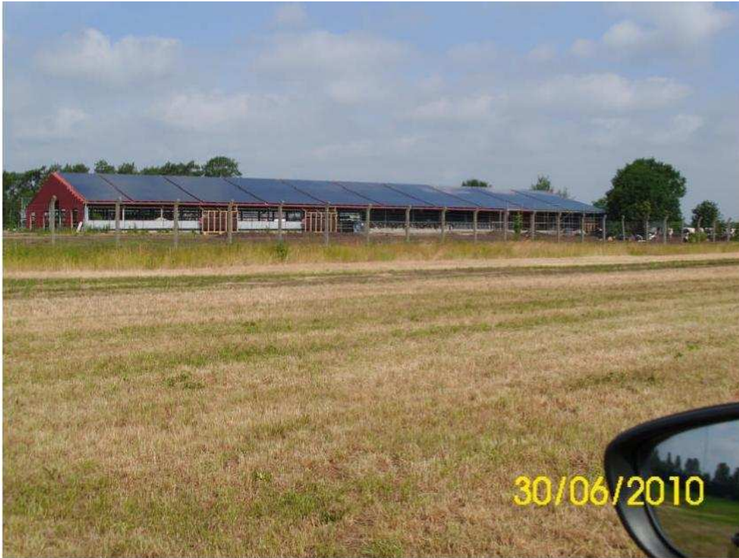
Photovoltaikanlage ca. 243 kWp in Vielank, Mecklenburg-Vorpommern, Belegung eines Kuhstalles mit micromorphen Dünnschichtmodulen
