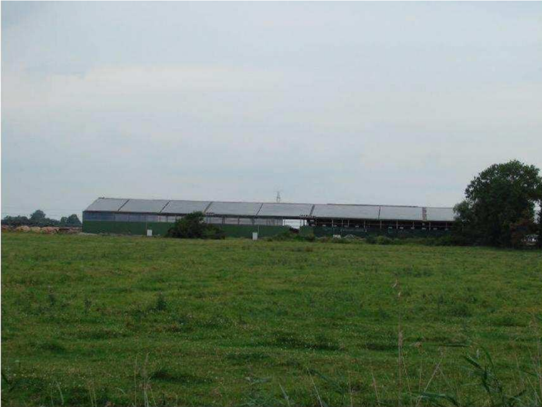
Photovoltaikanlage ca. 620 kWp in Nordenham, Niedersachsen, Belegung von Kuhställen und Maschinenhalle mit Dünnschichtmodulen und kristallinen Modulen
