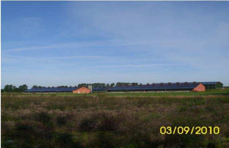
Photovoltaikanlage ca. 520 kWp in Bresegard, Mecklenburg-Vorpommern, Belegung von Bio-Putenställen mit mikromorphen Dünnschichtmodulen
